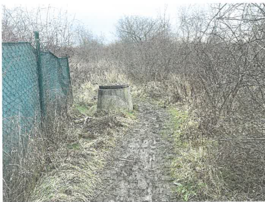
šachta v trase
